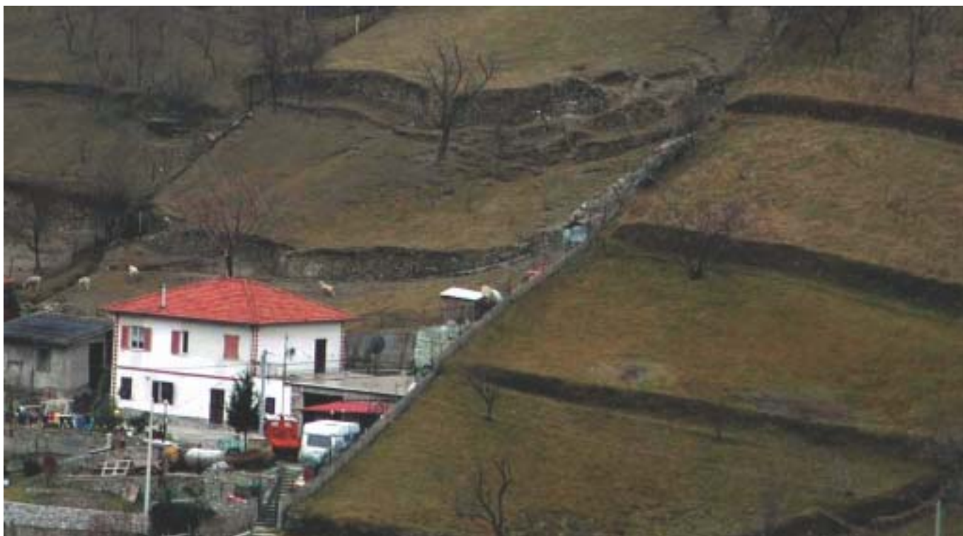
Foto 1 - Loc. Pernecco (Comune Serra Riccò - GE) - Argilliti di Montanesi. Evidenze morfologiche di una locale accelerazione del movimento in corrispondenza di terrazzamenti; si osservino le corone di distacco nella parte alta, le gibbosità nella zona d'accumulo in corrispondenza della fascia sottostante e l'assetto ribaltato verso monte dell'albero.
