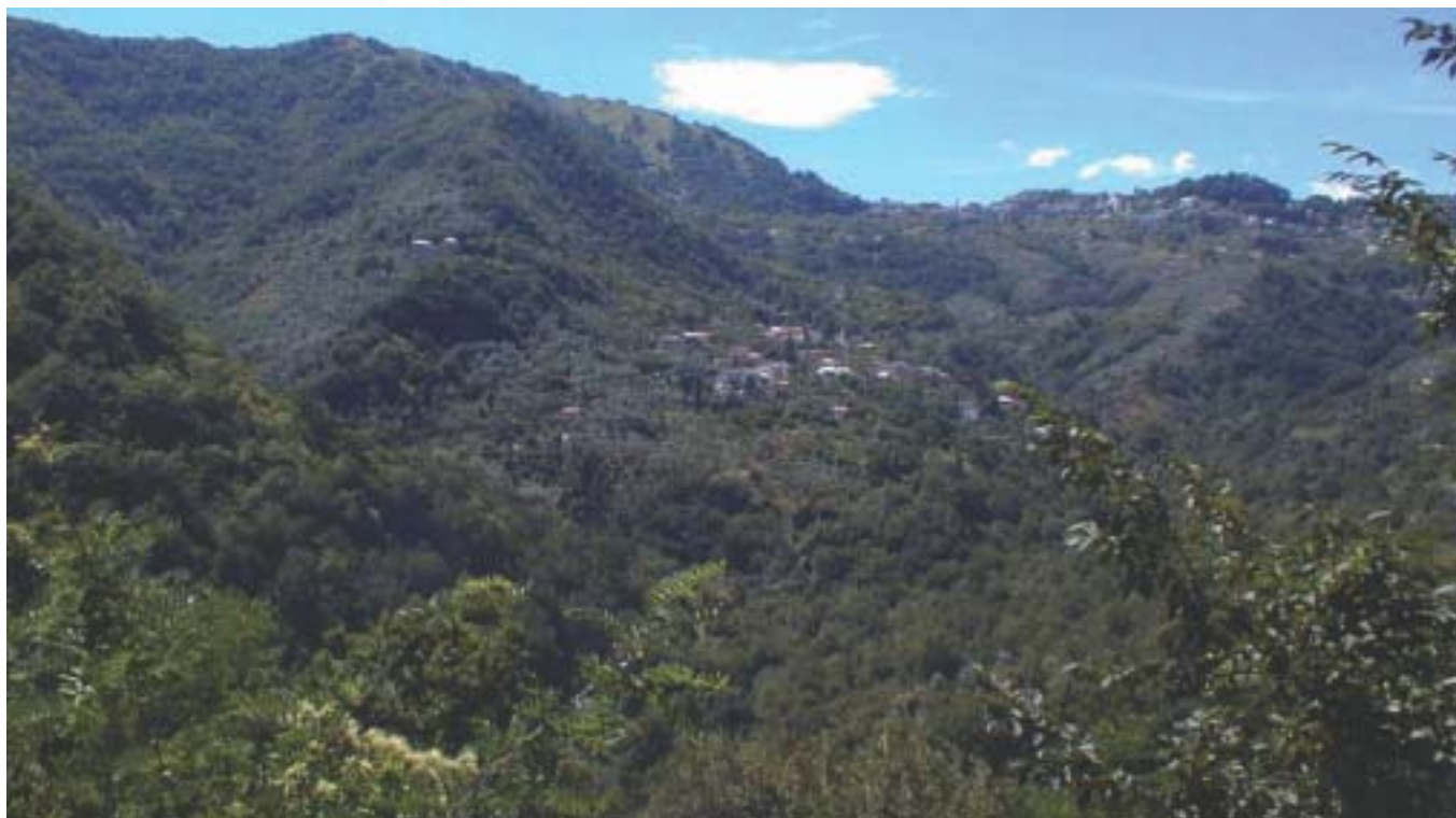
Foto 3 - Terrile di Uscio (Comune di Uscio, GE) - Flysch della Formazione di Monte Antola. Vista frontale del corpo di accumulo con ancora marcata la scarpata principale.
