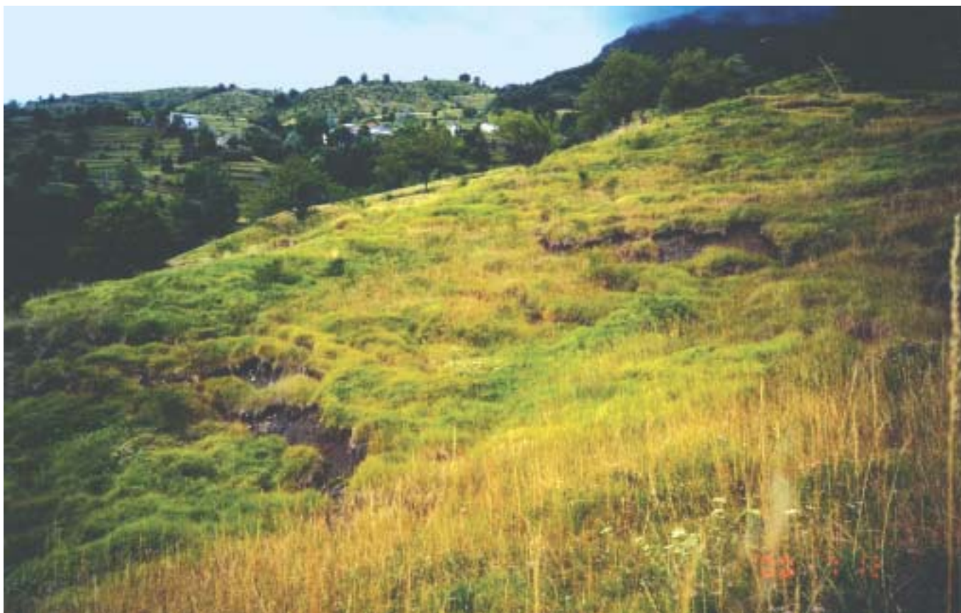
Foto 3 - Gavadi (Comune di S. Stefano d'Aveto - GE) - Arenarie di Casanova. Particolare delle piccole corone di distacco accompagnate da limitati ribassamenti della porzione di valle localizzate in un settore a più rapida evoluzione. Colamento tipo "earth slide" su detrito.
