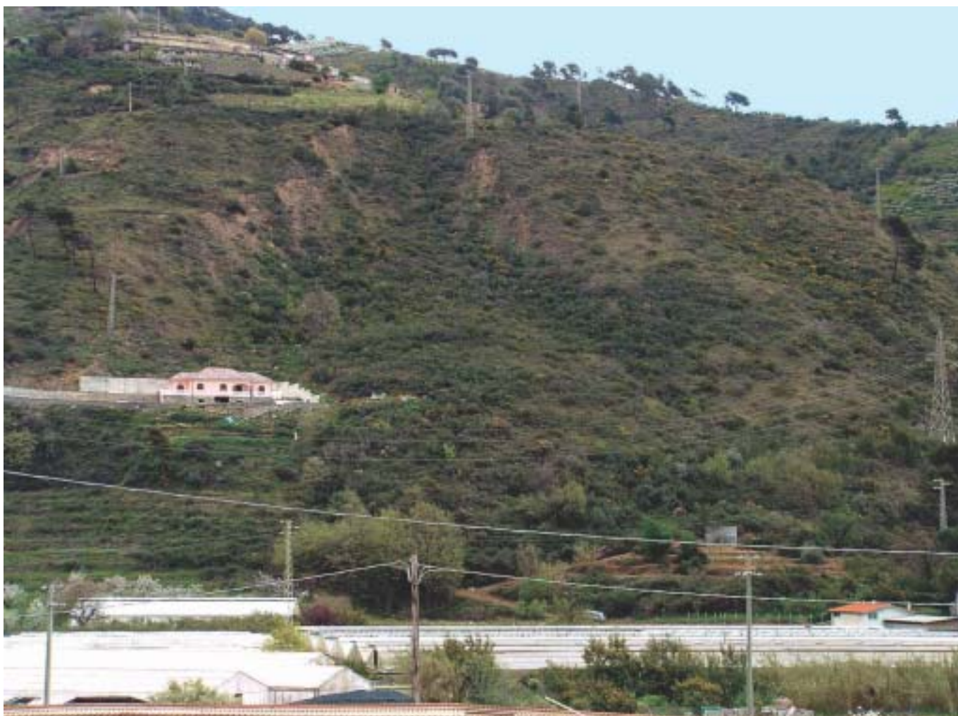
Foto 4.2.4 - Cian de Cà (Comune di Camporosso - IM) - Flysch di Ventimiglia. Risalta in maniera piuttosto evidente la zona di nicchia. Il corpo d'accumulo è interessata da gerbido mentre il piede insiste su un terrazzo alluvionale ed è terrazzato.
