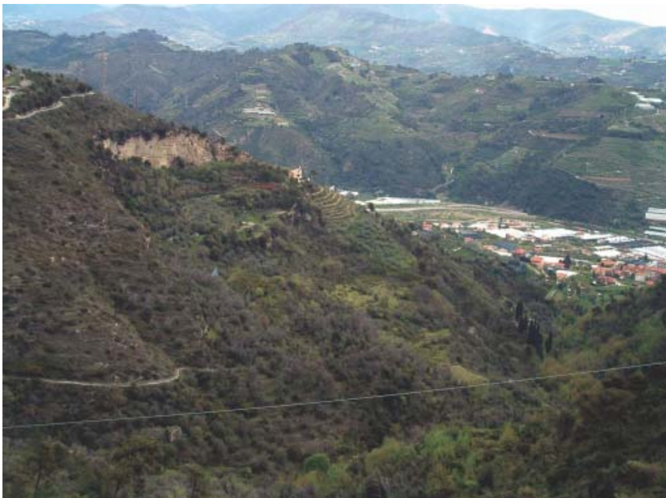
Foto 4.2.5 - Rio Ciaixe (Comune di Camporosso - IM) - Conglomerati, sabbie e argille plioceniche. Ben evidente la nicchia di distacco nei conglomerati. Probabilmente il fenomeno è da correlare al forte contrasto delle caratteristiche geomeccaniche interno ai sedimenti pliocenici, mentre l'innesco è da imputarsi all'incisione al piede da parte del rio ed al sollevamento della catena.
