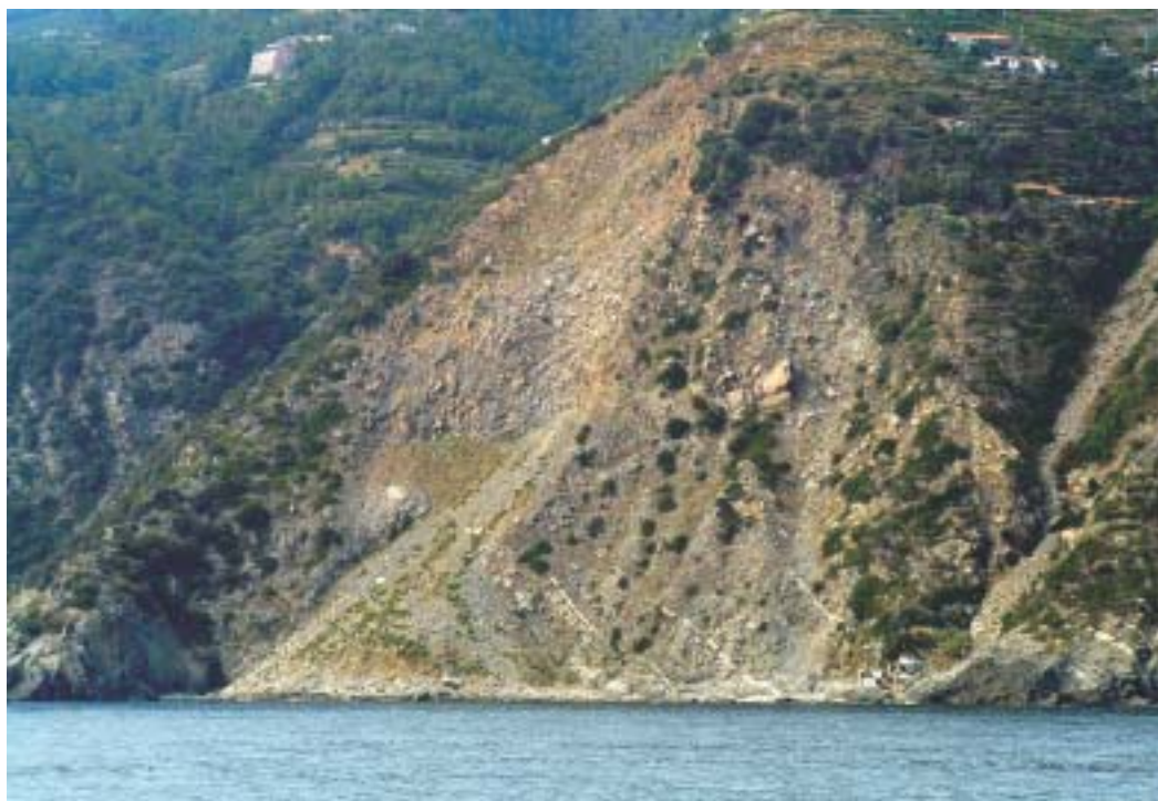
Foto 4.1.4 - Fossola (Comune della Spezia - SP) - Arenarie del Macigno. Crollo in massa. Si può osservare la nicchia di distacco cuneiforme e il cono di accumulo con il piede di forma arcuata. In questo caso è importante l'azione svolta dallo scalzamento al piede operato dal moto ondoso e le vibrazioni da esso indotte.
