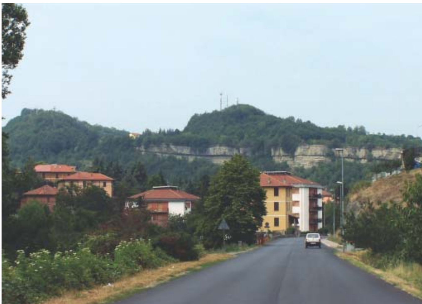
Foto 4.3.2 - Loc. Cengio Alto (Comune di Cengio - SV) - Formazione di Rocchetta (BTP) Frana planare relitta. L'immagine evidenzia il piano di scivolamento e la zolla traslata
