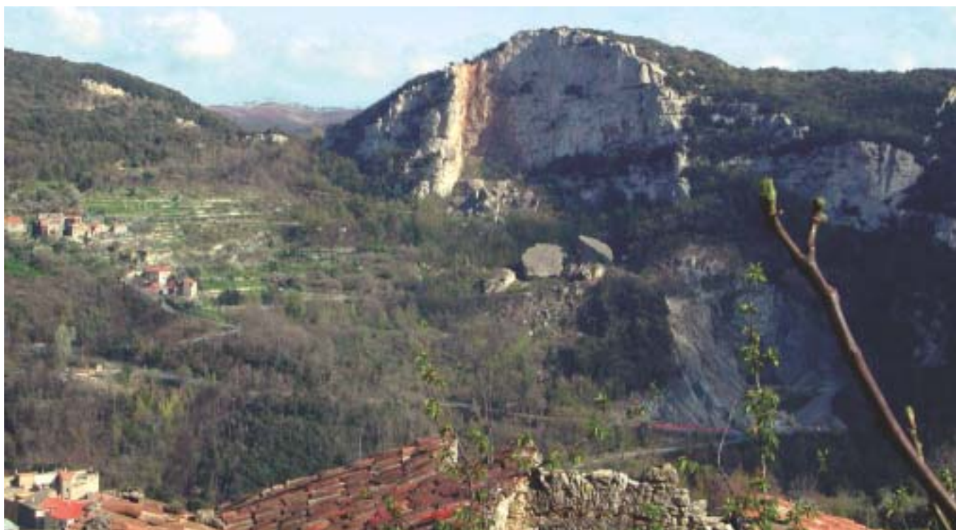
Foto 4.1.3 - Magnone inferiore (Comune di Vezzi Portio - SV) - Pietra di Finale. Frana di crollo. Si possono facilmente individuare la zona di nicchia ed i blocchi ciclopici collassati e rotolati alcune decine di metri più a valle rispetto al piede della falesia.
