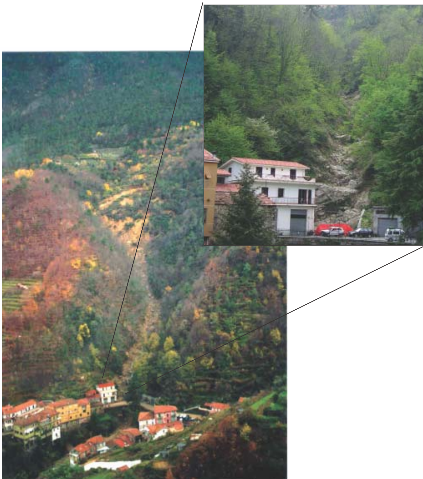
Foto 4.5.1- Rio Crai - Ceriana (Comune di Ceriana - IM) - Arenarie di Bordighera. Debris flow innescatosi durante evento alluvionale del novembre 2000. L'immagine mostra la zona di innesco e la zona di flusso, lungo il corso del rio, mentre è poco sviluppata, e praticamente assente, la conoide di deiezione che è "defluita" nell'alveo del T. Armea. Nella fattispecie, le analisi post-evento hanno accertato quale causa predisponente la giacitura a franapoggio della stratificazione che favorendo il "drenaggio" verso valle delle falde temporanee ha portato all'innescio del fenomeno franoso "madre", nella zona di testata (tipo scorrimento/scivolamento).
