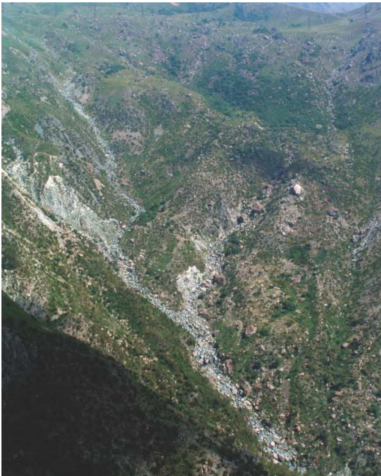
Foto 4.5.3 - Bacino T. Varenna - Rio Gandolfi (Comune di Genova - GE) - Colatori confluenti di basso ordine gerarchico interessati da debris flow che hanno lasciato nell'alveo parte del carico solido più grossolano. Sulla sinistra si osserva l'area di alimentazione di uno di questi, per il quale la nicchia evolve con fenomeni di crollo.
