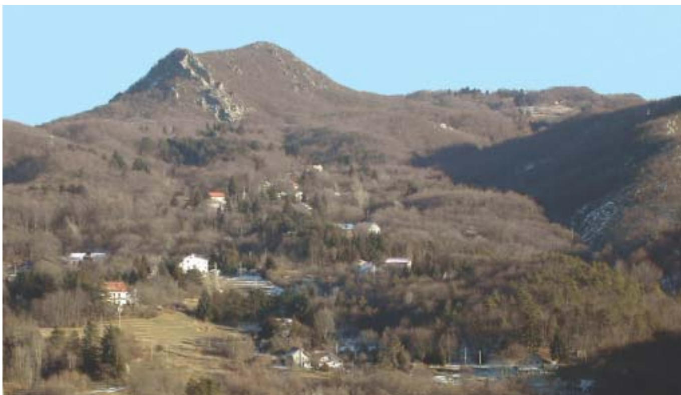
Foto 5.10 - Ambito territoriale dei terreni metamorfici tettonizzati - Sotto-Ambito del Gruppo di Voltri. Vista della località Marasca insediata su un grosso corpo di frana relitta, impostata su una zona di contatto tra rocce metasedimentarie e "rocce verdi"
