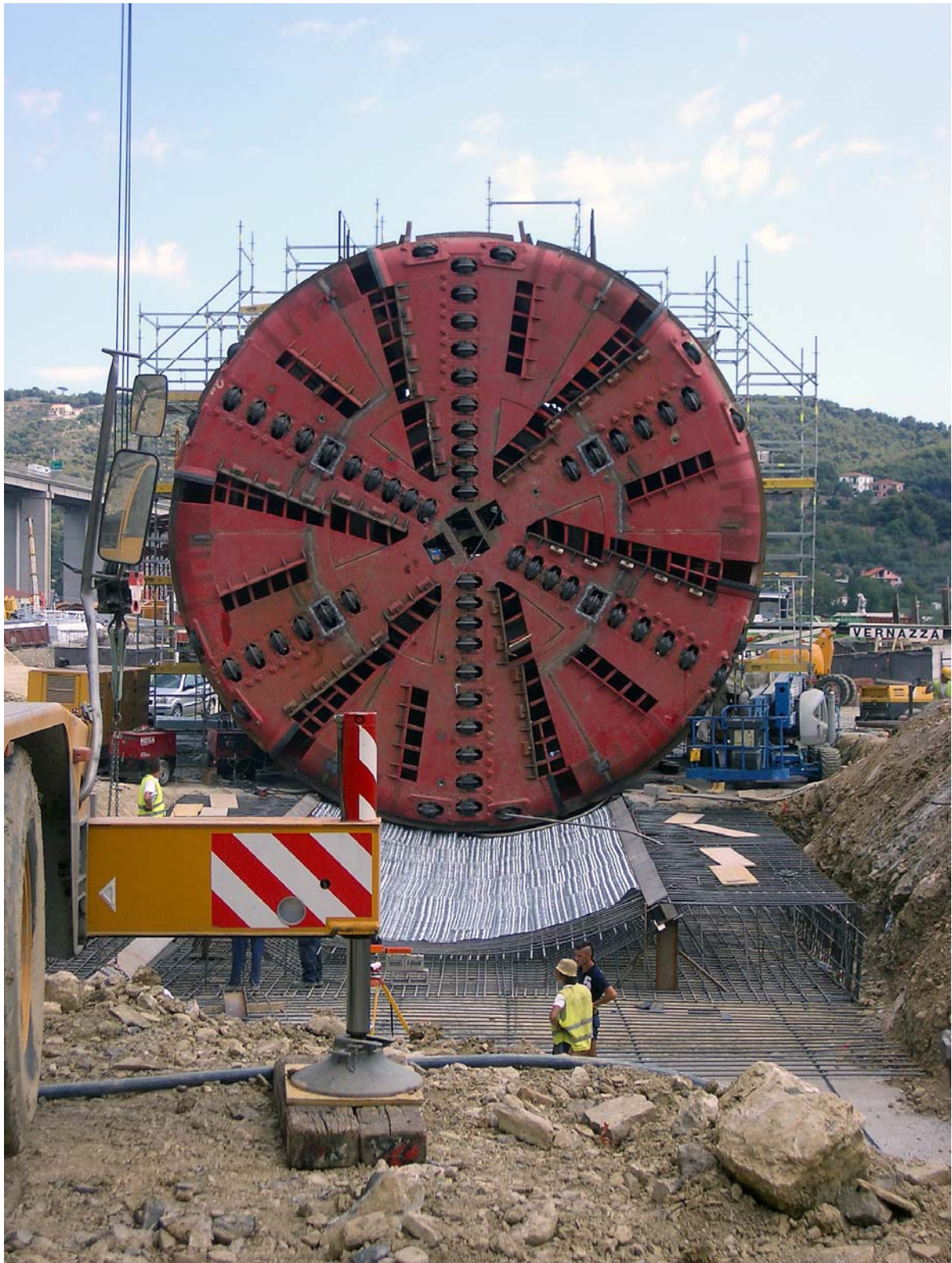
Figura 1: immagini dal cantiere per il raddoppio della tratta ferroviaria del ponente ligure nella tratta Andora San Lorenzo al mare: la fase di assemblaggio della TBM (Tunnel Boring Machine) all'imbocco della galleria Collecervo.
